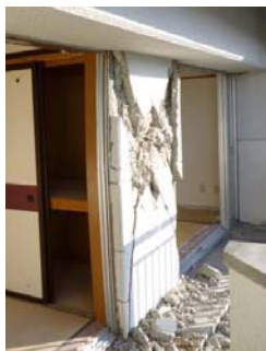
东日本大地震中满足建筑基准法的要求未造成人员伤亡却因受损严重而被迫拆除的公寓 摄影：真田靖士
