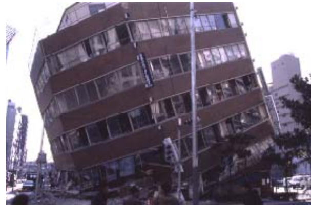
阪神淡路大地震中倒塌的建筑物
