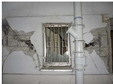
东日本大地震中满足建筑基准法的要求未造成人员伤亡却因受损严重而被迫拆除的公寓 摄影：真田靖士
