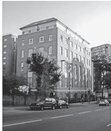
ブリティッシュテレコム電話局舎の集合住宅へのコンバージョン(ロンドン・リージェントパーク)
