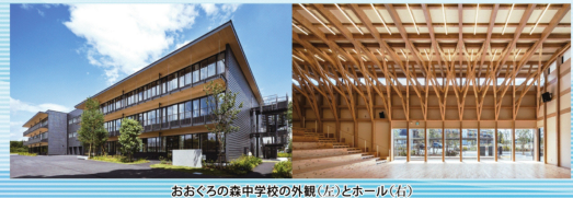
おおくろの森中学校の外観(左)とホール(右)
