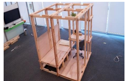
【木製内装システムの開発】 建設業界では将来、熟練技能者が不足するため、居住者がセルフビルドで組み立て可能な内装システムを開発
