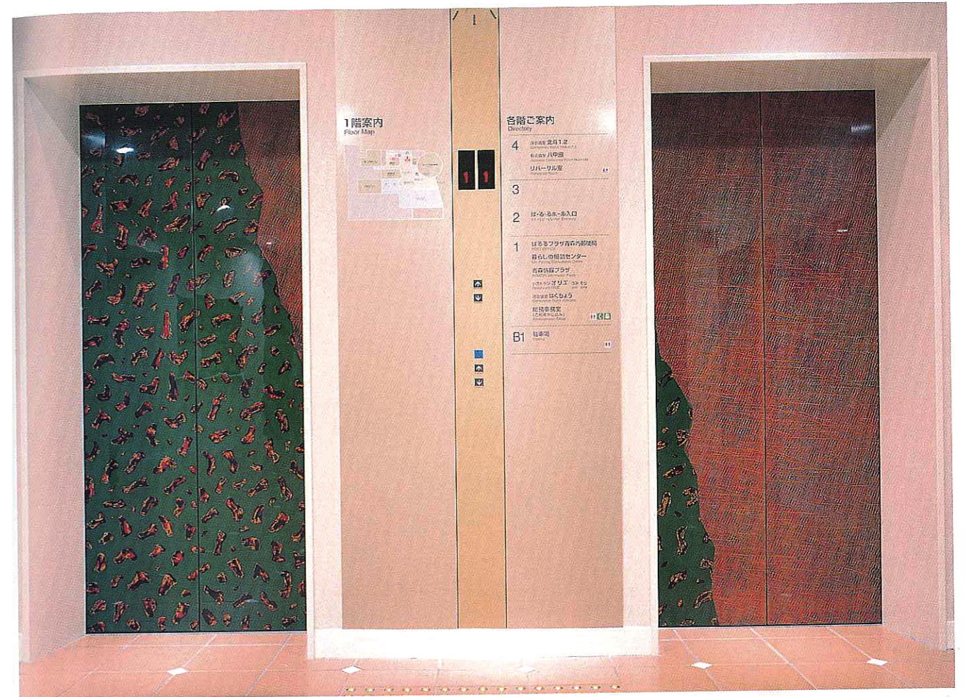
エレベータ乗場扉に用いられた津軽塗
