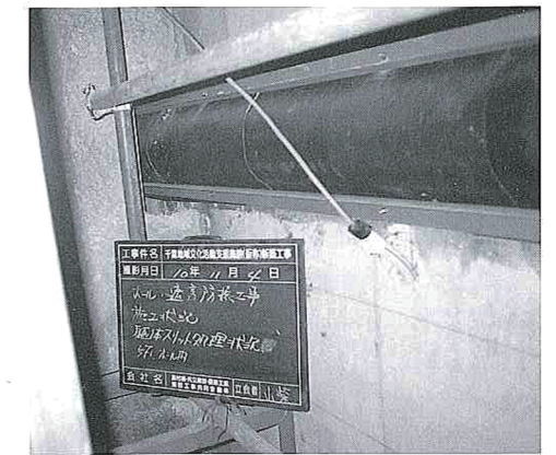
写真5 層間変位対応スリット
