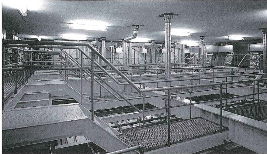
5階 ば・る・るホール天井上部
