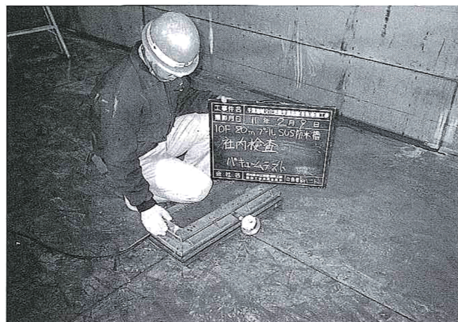
写真5 底面の真空検査
