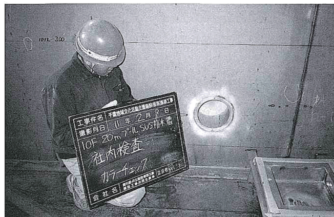
写真6 コーナー部の浸透検査
